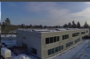
D'avril 2020 à mars 2021 le second œuvre se poursuit... même sous la neige
