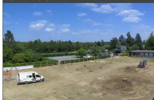
Juillet 2019 Département du chantier et terrassement
